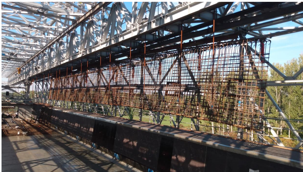
Obr. 105 Osadzovanie armokoša (D4 - Bratislava, 2019).
