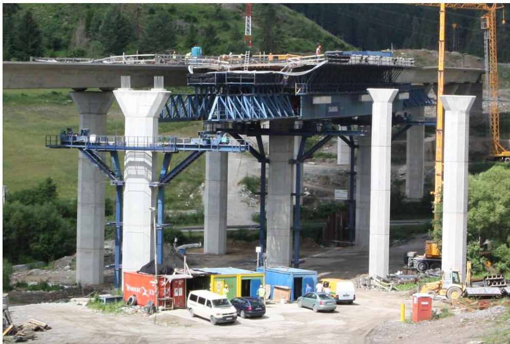
Obr. 89 Krátke konzoly uchytené na piliere s podopretím na základe (D1 Hubová - Ivachnová, 2017).
