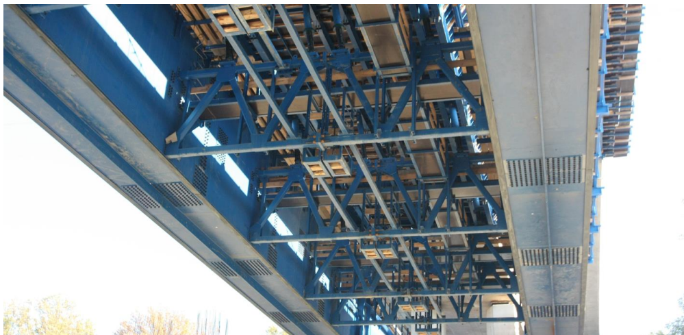
Obr. 91 Priečniky medzi hlavnými trámami skruže.
