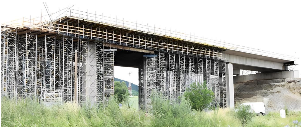
Obr. 25 Výstavba mostov pomocou pevnej skruže (premostenie cesty oceľovými nosníkmi)
