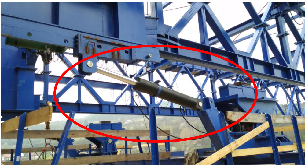
Obr. 81 Hydraulický piest na posun výsuvnej skruže
