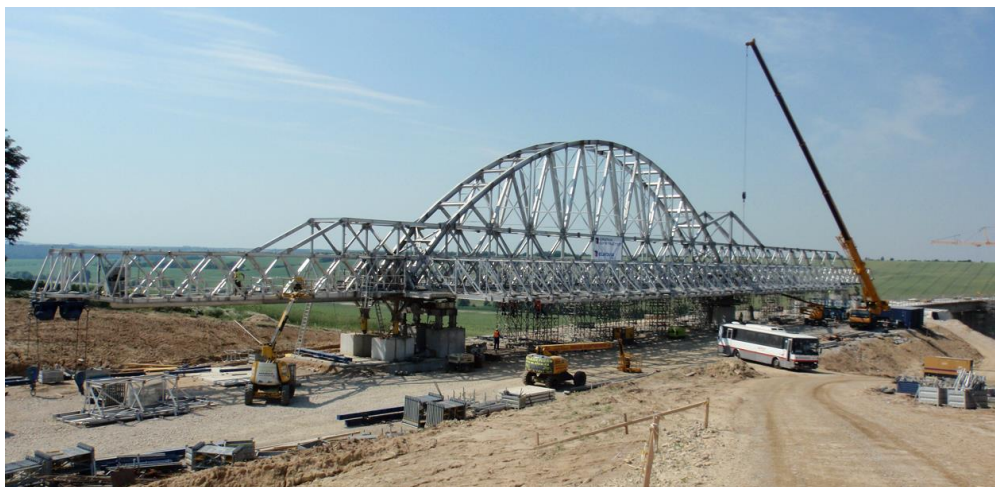
Obr. 102 Montáž výsuvnej skruže za oporou (R1 Selenec - Beladice, 2010).
