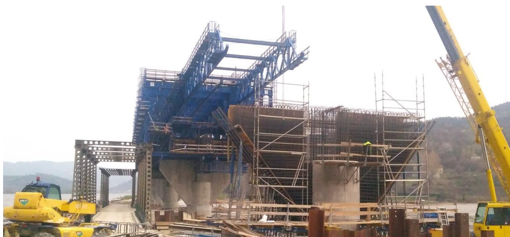
Obr. 15 Výstavba mosta cez Nosickú priehradu (2019).
