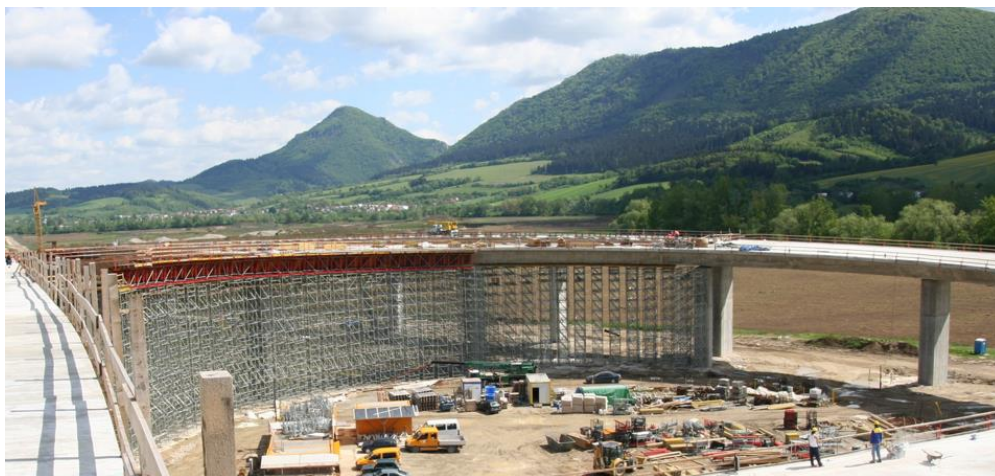
Obr. 27 Výstavba mostov pomocou pevnej skruže (predpríprava debnenia v ďalšom poli)
