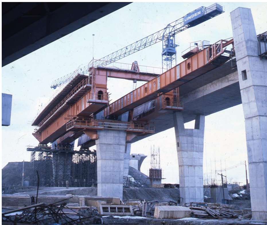
Obr. 97 Výsuvná skruž nasadená na výstavbu estakády Prístavného mosta. V prednej časti sú dva krajné hlavné trámy prepojené tuhým rámom. Na pilieroch sú z boku viditeľné kapsy pre uchytenie krátkych oceľových konzol. (1982, TASR)
