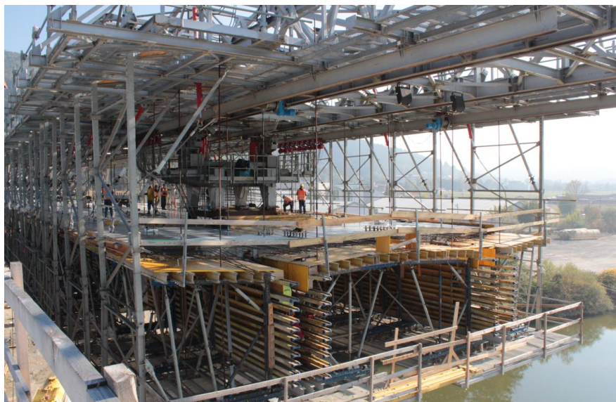
Obr. 104 Pohľad na debnenie segmentu dvoj-trámového prierezu. Výsuvná skruž s horným trámom (D3, Hričov. Podhradie - Žilina, 2016).
