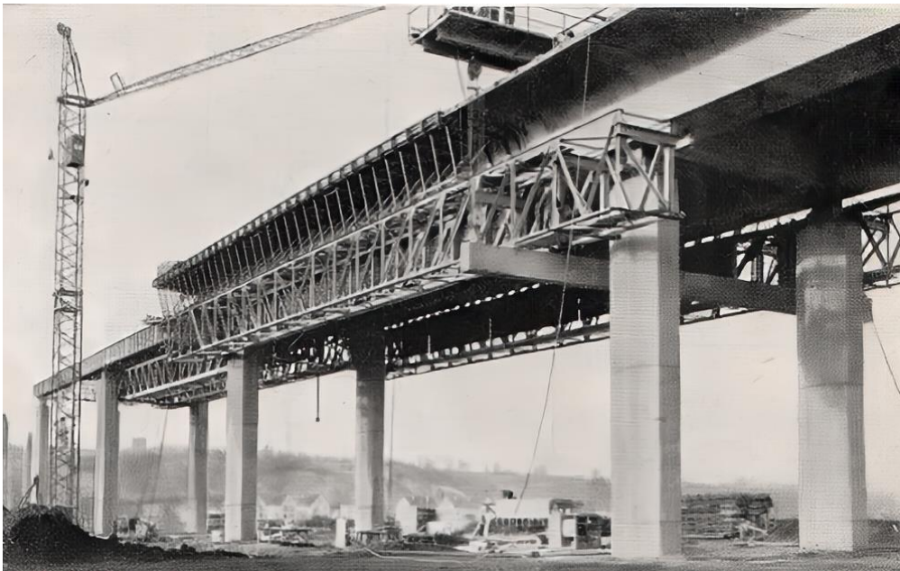
Obr. 7 Fotka z výstavby mosta Kettiger Hangbrücke [6].
