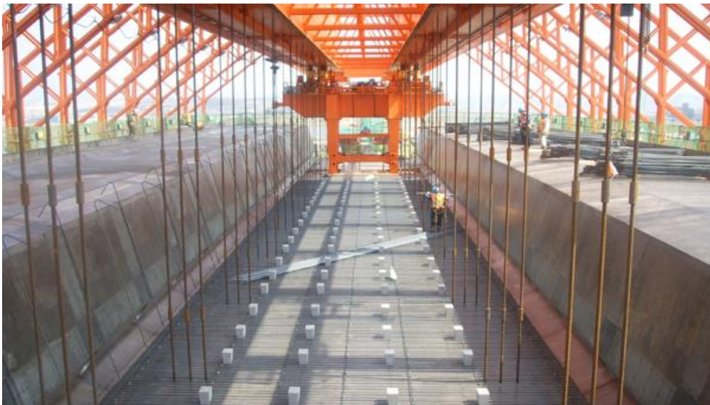
Obr. 78 Závesy debnenia
