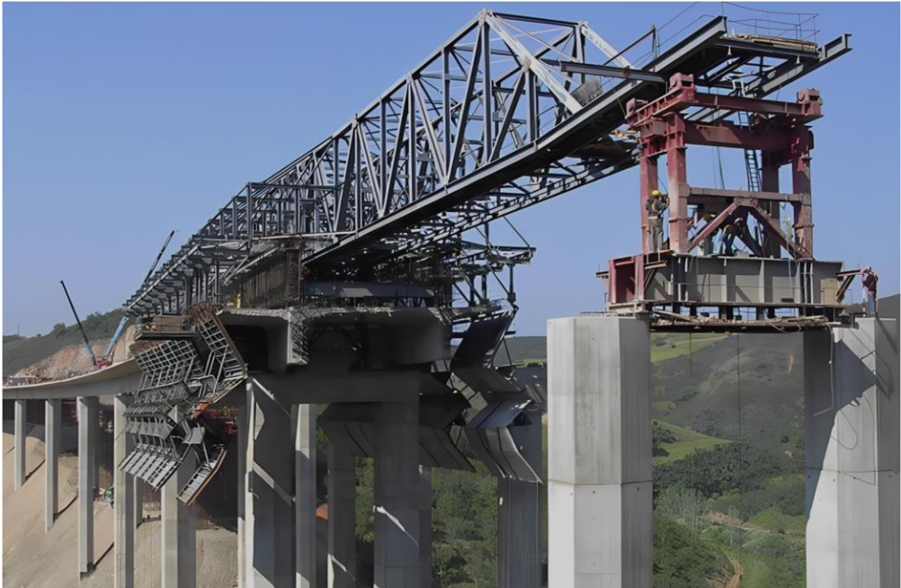
Obr. 32 Výsuvná skruž s horným trámom – presun do ďalšieho záberu (ScS)
