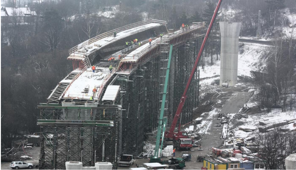
Obr. 29 Výstavba mosta v smere od stredu k oporám (Svrčinovec, 2015)
