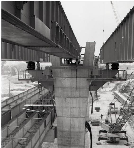
Obr. 96 Úprava piliera v mieste hlavice pre stredový trám výsuvnej skruže (estakády Prístavného mosta, 1980, Š. Petráš – TASR)
