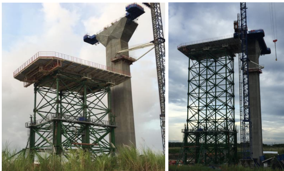
Obr. 59 Zdvíhanie debnenia pri výstavbe mosta Panama Bridge 2 [22]
