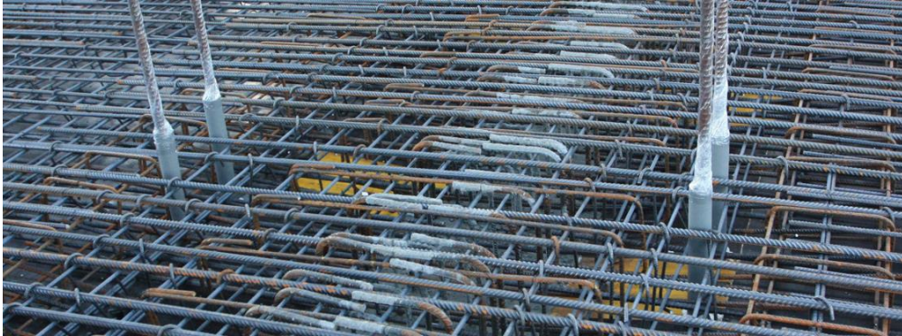
Obr. 79 Obalené závesy debnenia pred betonážou
