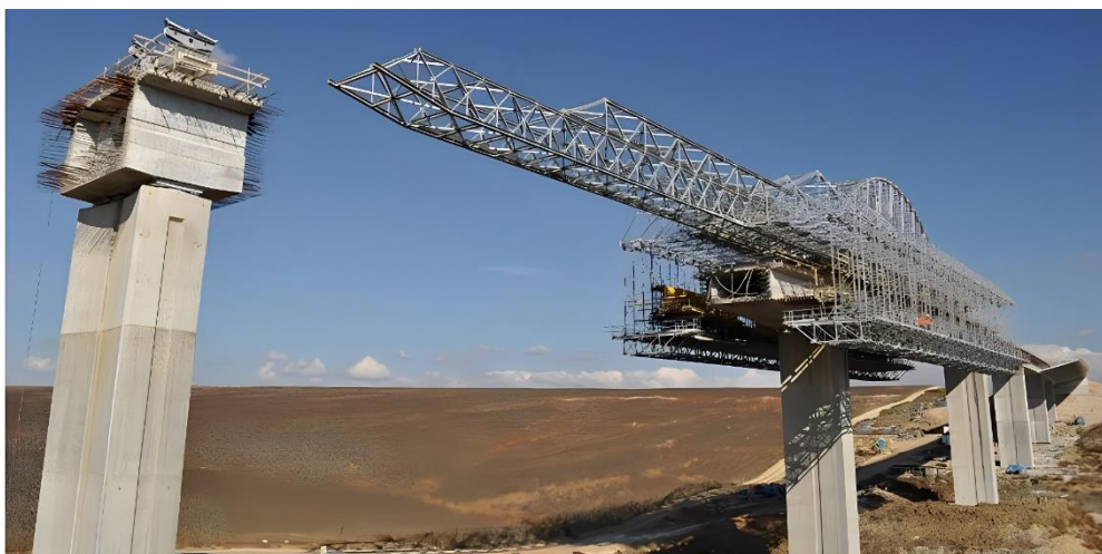
Obr. 10 Výstavba mosta na rýchlostnej ceste R1 pri Nitre (2010) [7].
