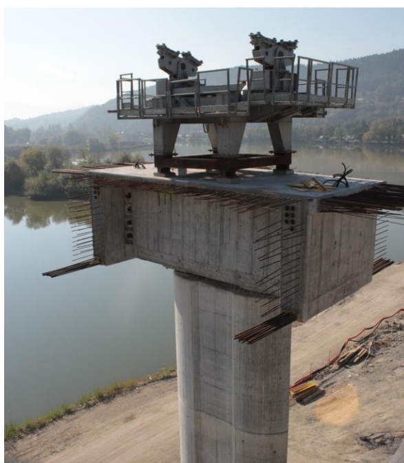
Obr. 74 Osadená podpera na predpripravený priečnik (D3, Hričov. Podhradie - Žilina, 2016)
