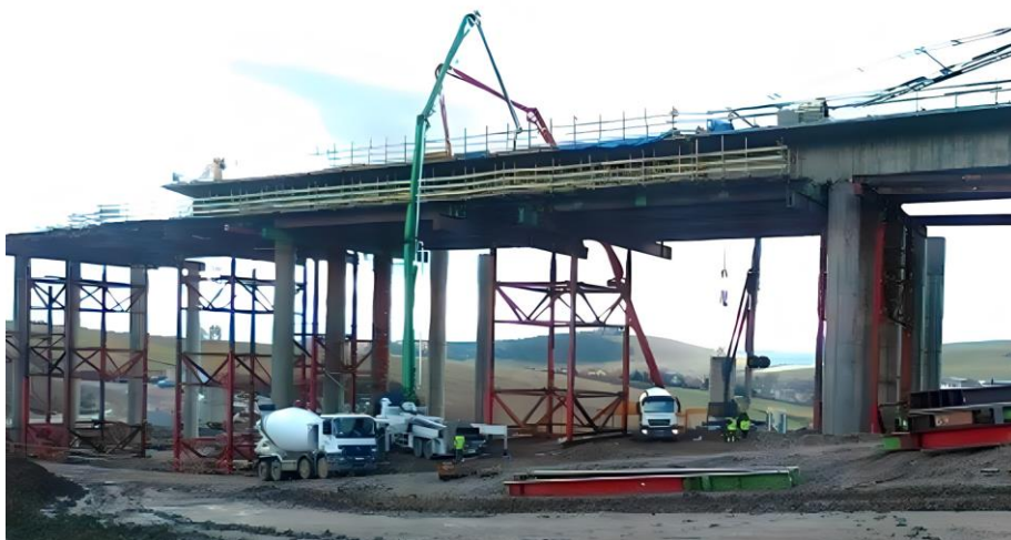
Obr. 48 Pohľad na skruž počas betonáže (ScS).
