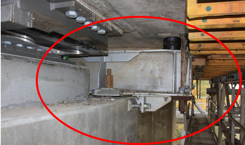
Obr. 77 Stabilizácia predpripraveného priečnika na pilieri hydraulickými valcami a závitovými tyčami (D4 Bratislava, 2019)
