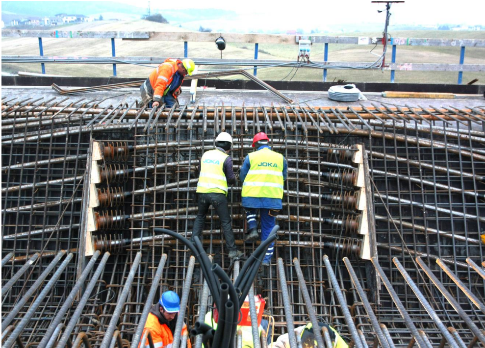
Obr. 45 Prekotvované káble v mieste priečnika (Hričov. Podhradie – Lietavská Lúčka, 2015).
