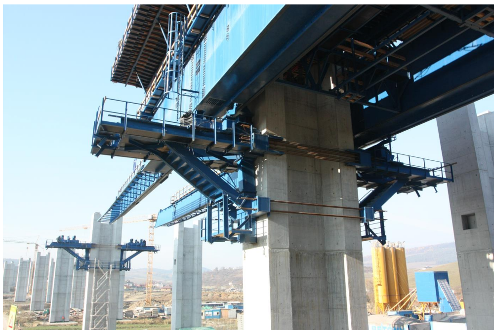
Obr. 88 Krátke konzoly uchytané na piliere (D1 Hričov. Podhradie – Lietavská Lúčka, 2015).
