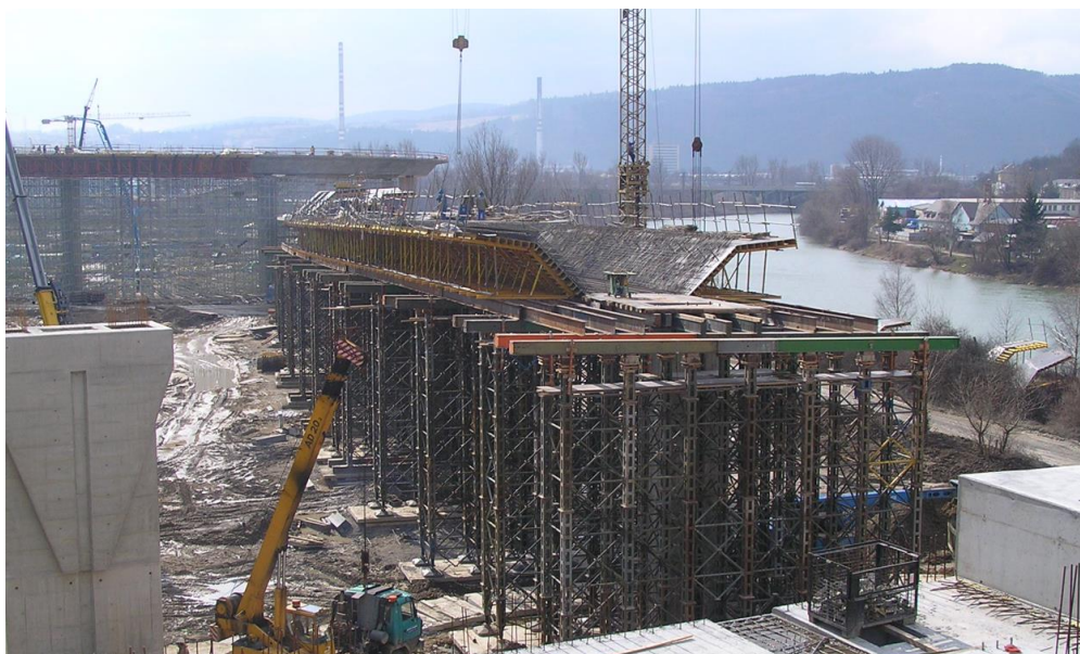
Obr. 19 Výstavba mostov pomocou pevnej skruže (Považská Bystrica, 2009).
