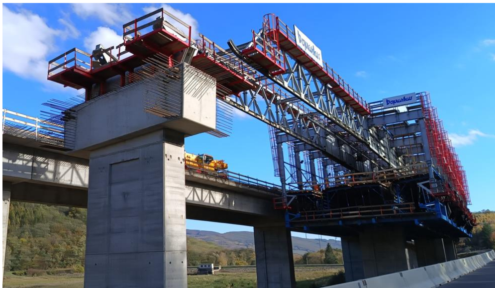
Obr. 70 Výsuvná skruž s dvoma hornými trámami (R2 Kriváň – Mýtňa, 2023).
