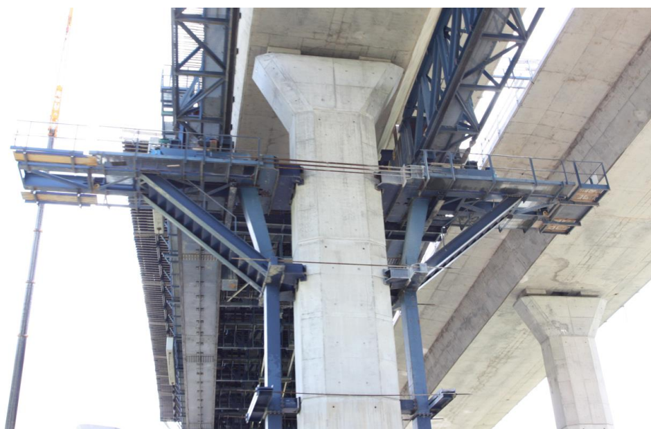
Obr. 90 Krátke konzoly uchytené na piliere s podopretím na základe (D1 Hubová - Ivachnová, 2017).
