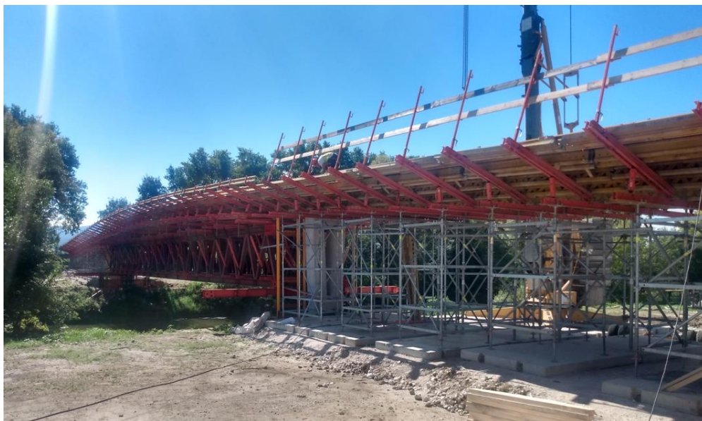
Obr. 22 Výstavba lávky pre peších v Topolčanoch (max. rozpätie lávky 38m, 2020).
