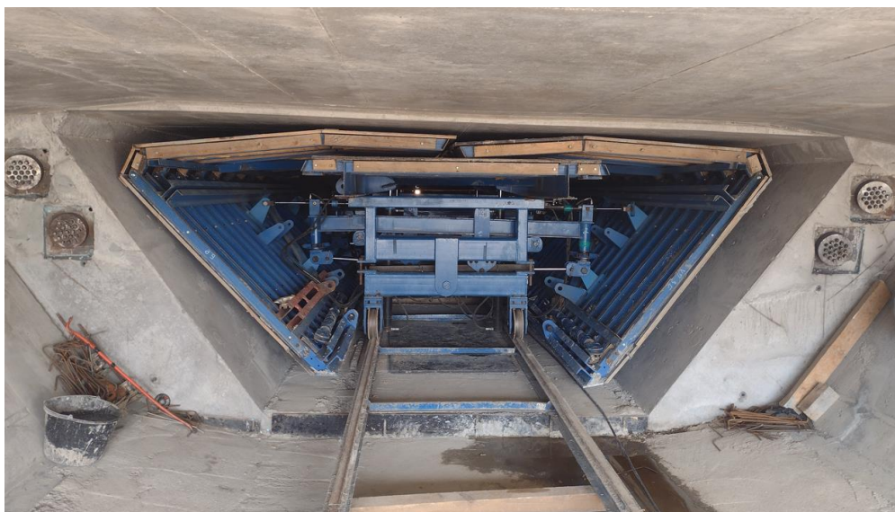
Obr. 94 Debniaci vozík vnútorného debnenia v zloženom tvare pri prechode cez "otvorený" priečnik.
