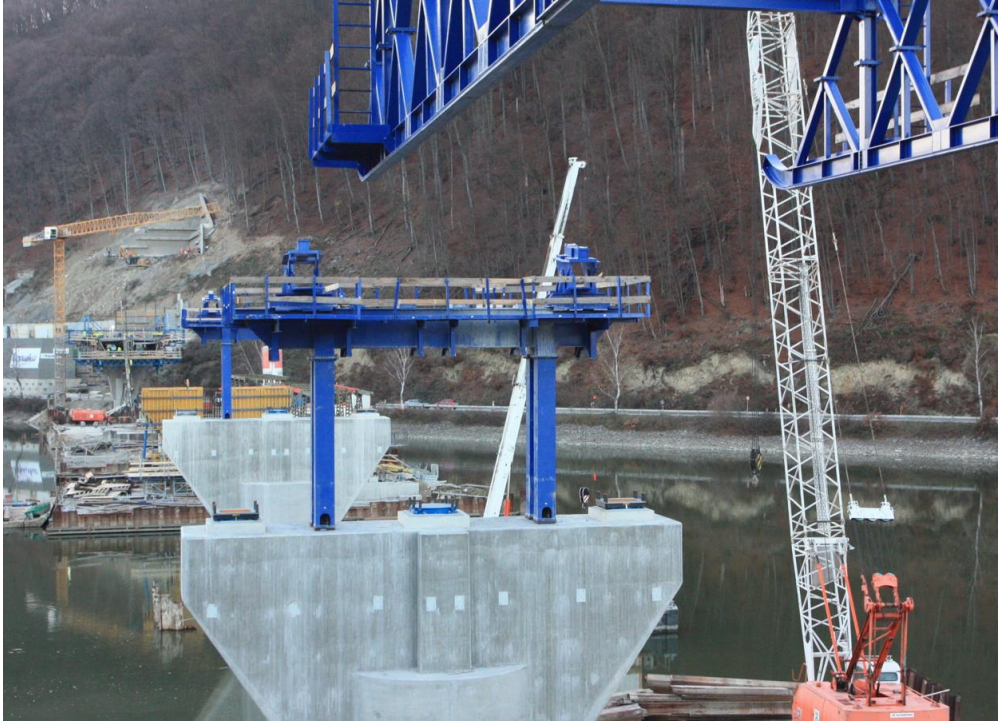
Obr. 71 Oceľové podpery výsuvnej skruže umiestnené na piliere (výstavba železničného mosta ponad Nosickú priehradu, 2018).
