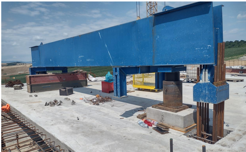
Obr. 92 Priečnik na podvesenie skruže.
