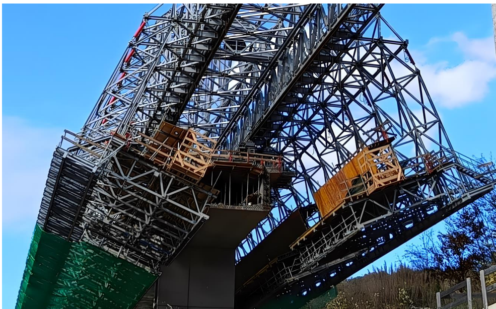
Obr. 65 Roztvořená skruž – detailný pohľad. Viditeľné červené hydraulické piesty umožňujúce roztvorenie skruže (R2 Kriváň – Mýtňa, 2023).
