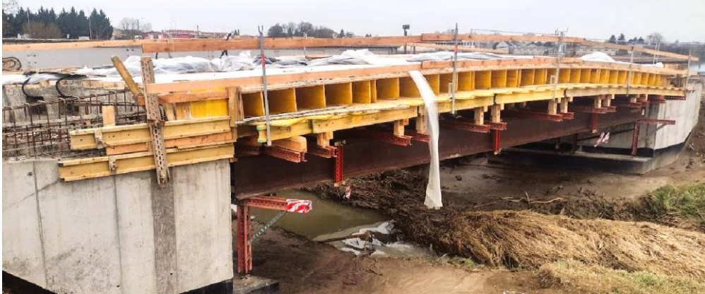
Obr. 23 Podperná skruž pre debnenie lávky ponad potok (Holíč, 2023)
