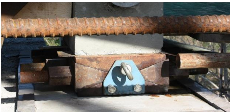
Obr. 54 Odsksružovacie kliny
