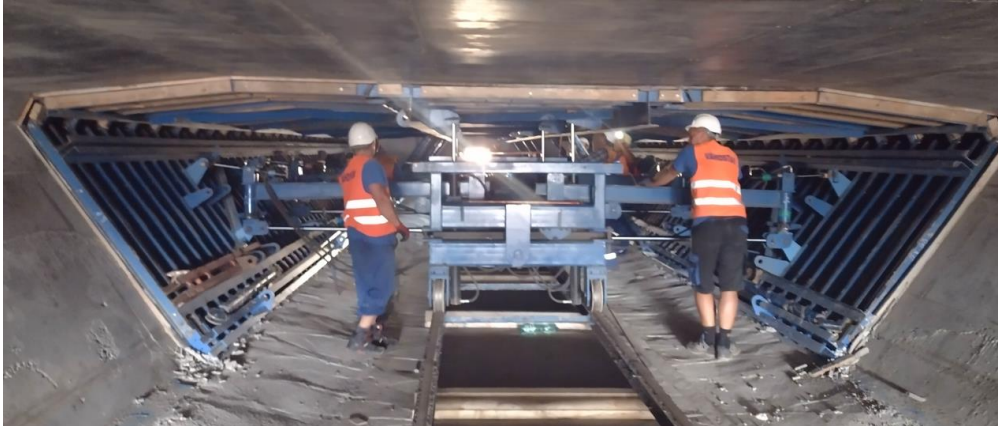
Obr. 95 Debniaci vozík vnútorného debnenia v rozloženom stave – oddebňovanie komory.
