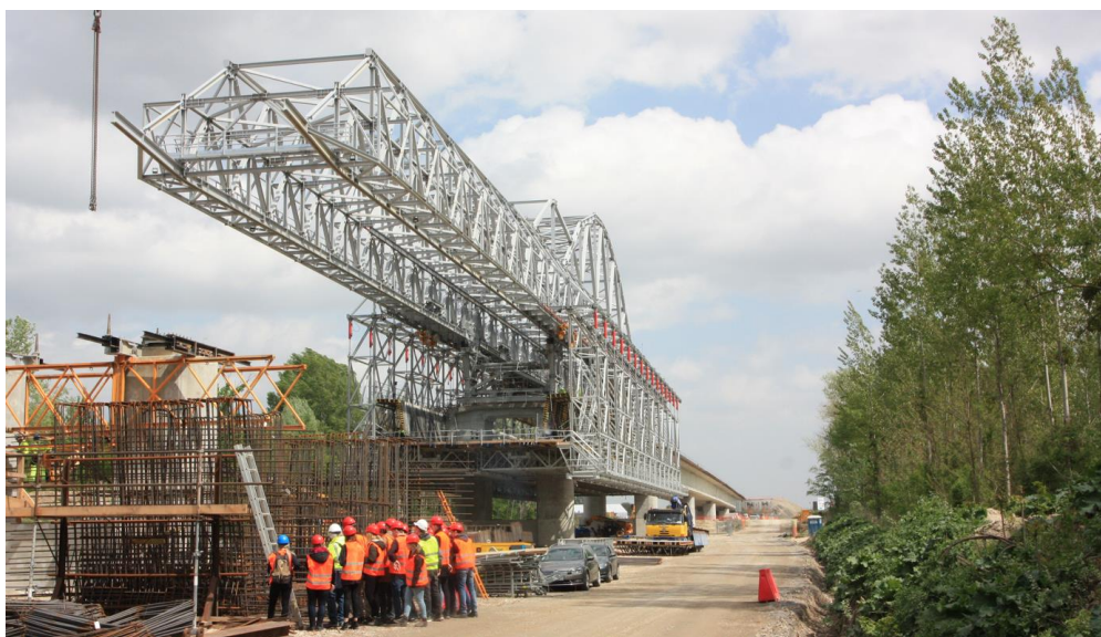
Obr. 13 Výstavba ľavo-brežnej estakády (D4 – Bratislava, 2019).
