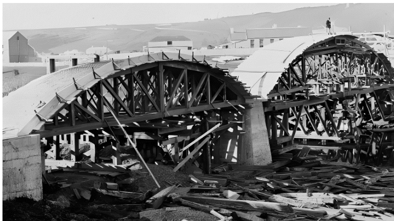
Obr. 2 Fotka z výstavby podobného mosta z rovnakého obdobia.
