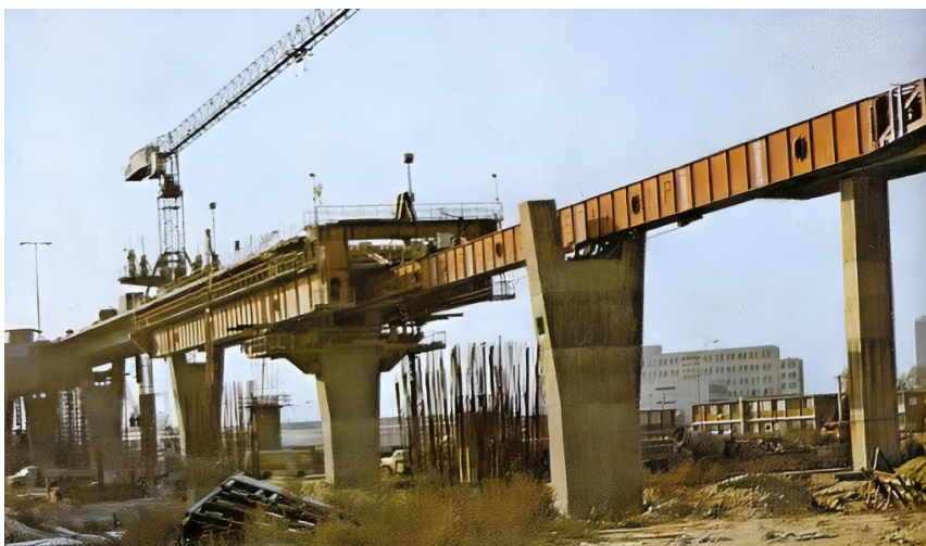
Obr. 8 Výstavba predpolí mosta Hrdinov Dukly (dnes Prístavný most) [1].
