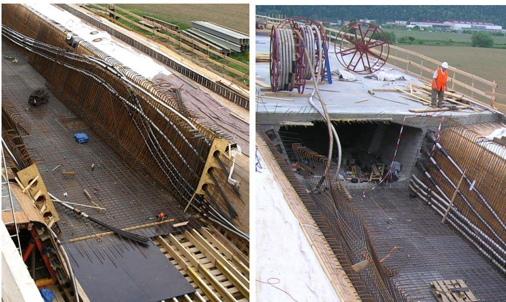
Obr. 46 Spojkovanie polovice káblov pred a po betonáži (Lahovice – Slivenec, ČR, 2009).
