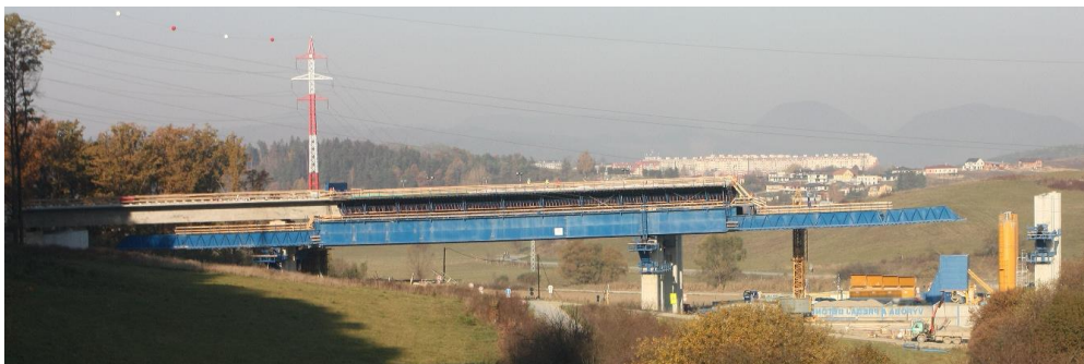
Obr. 35 Výsuvná skruž s dolným trámom (Hričovské Podhradie -Lietavská Lúčka, 2015, pozn. pre názornosť - zrkadlový obraz)
