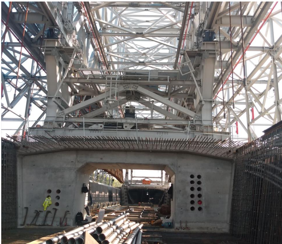
Obr. 76 Predpripravený priechník a osadená podpera výsuvnej skruže (D4 Bratislava, 2019)
