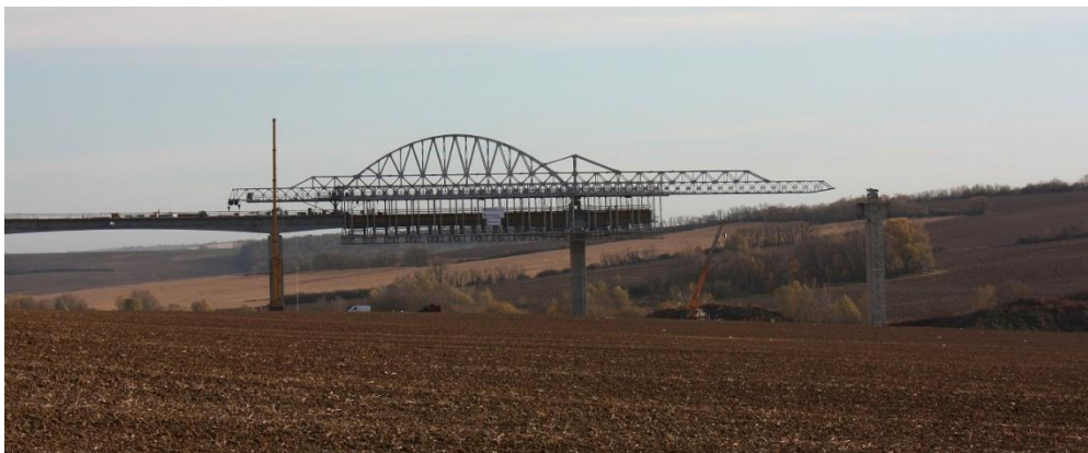
Obr. 111 Portugalská výsuvná skruž nasadená v rámci výstavby rýchlostnej cesty R1 Selenc – Beladice v roku 2010. Jedna z prvých aplikácií skruže so systémom OPS na Svete.
