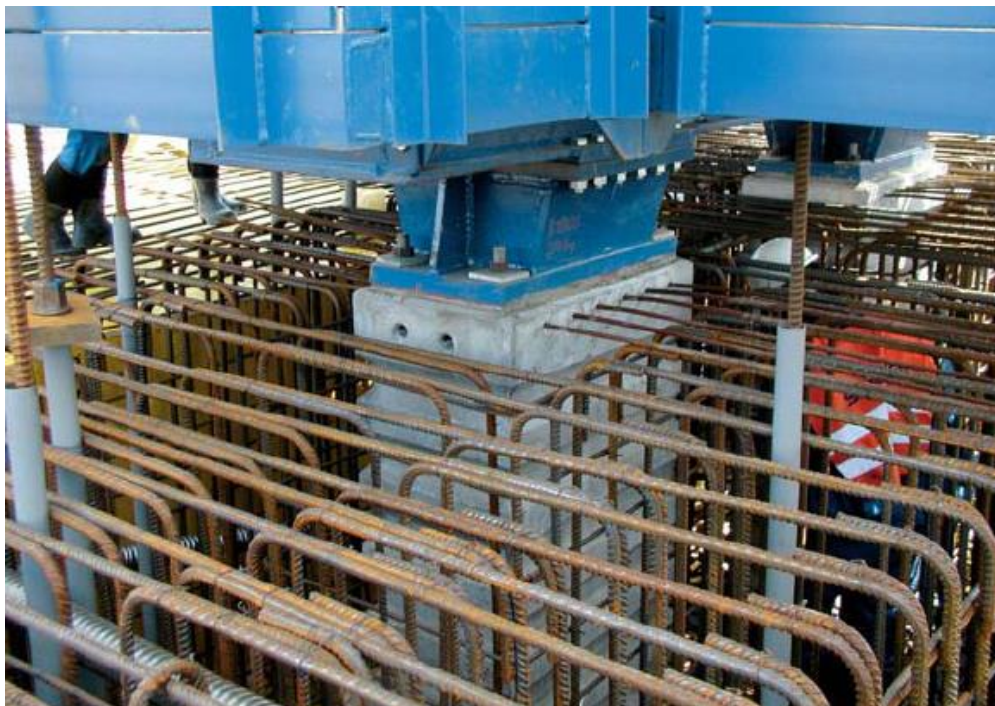
Obr. 73 Oceľové podpery výsuvnej skruže umiestnené na piliere prostredníctvom betónových prefabrikovaných stĺpikov.
