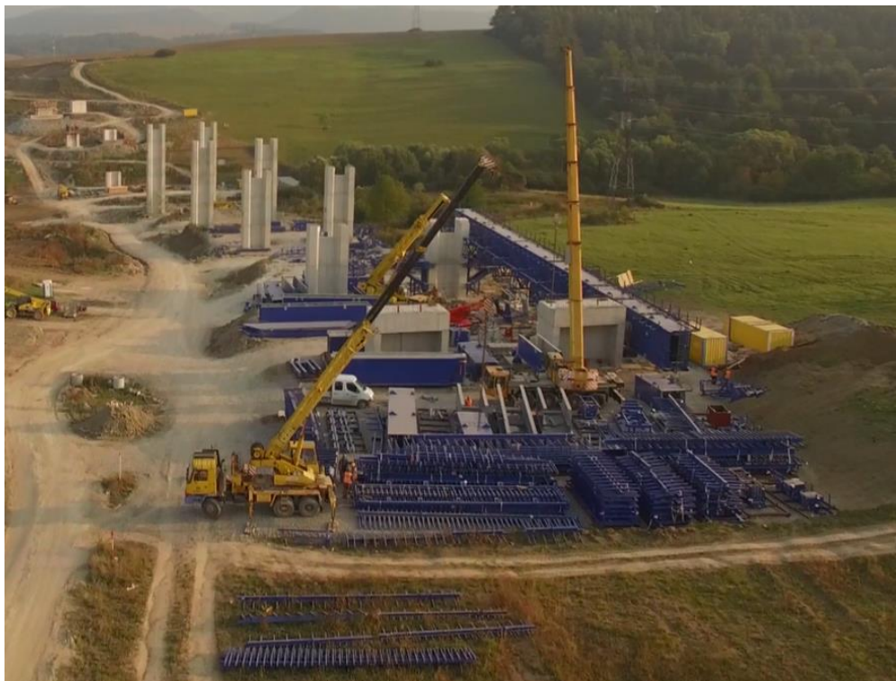
Obr. 101 Montáž skruže (D1 Hričov. Podhradie – Lietavská Lúčka, 2015) ScS.
