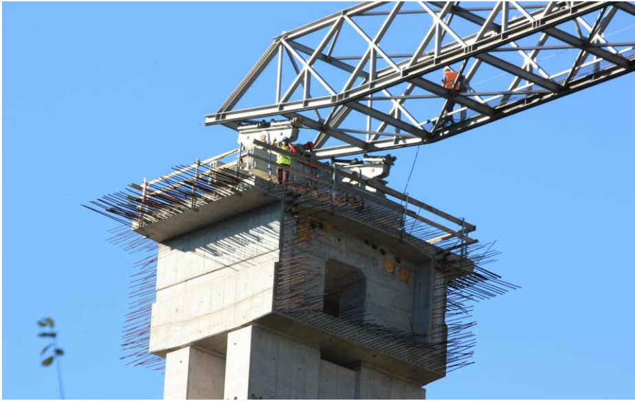
Obr. 75 Nabiehanie výsuvného nosa skruže na podperu osadenú na predpripravený priechník (D1, Jánovce - Jablonov, 2014)
